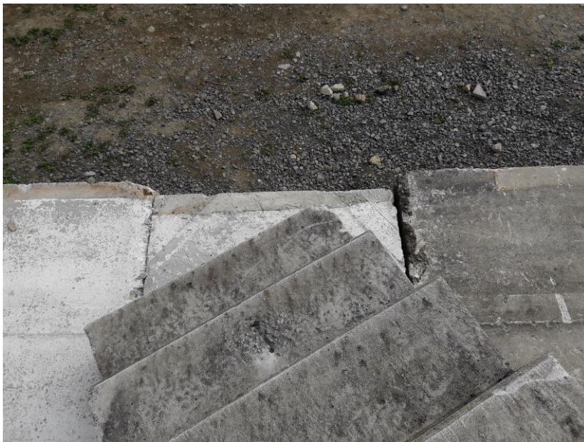
Bild 18: Absturzgefahr von Ebene 3.
