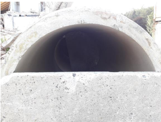
Bild 5: Verengter Einstieg in einen der Bergungsgänge.
