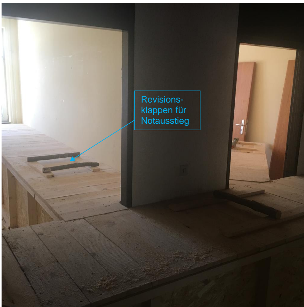
Bild 3: Beispiel für einen Notausstieg Gebäude 3
