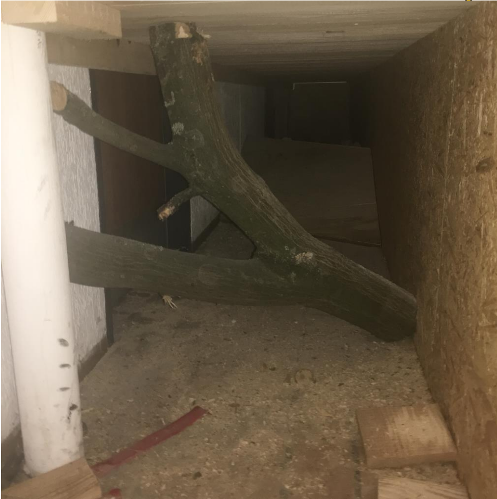
Bild 4: Beispiel Tunnel innen Gebäude 3
