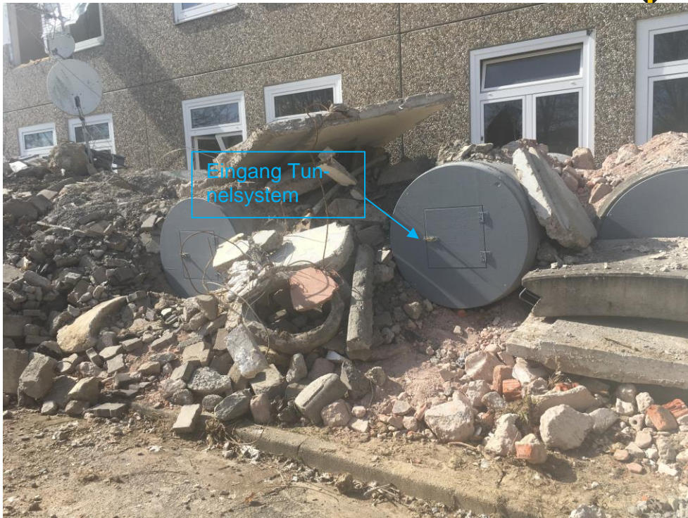
Bild 2: Eingang zum Tunnelsystem Gebäude 3
