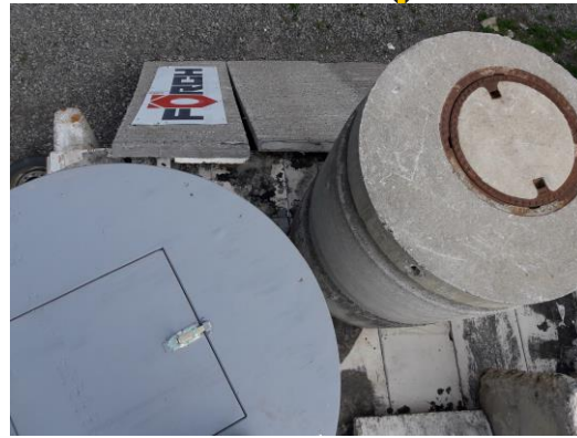
Bild 20: PSA & Absturzsicherung beachten
