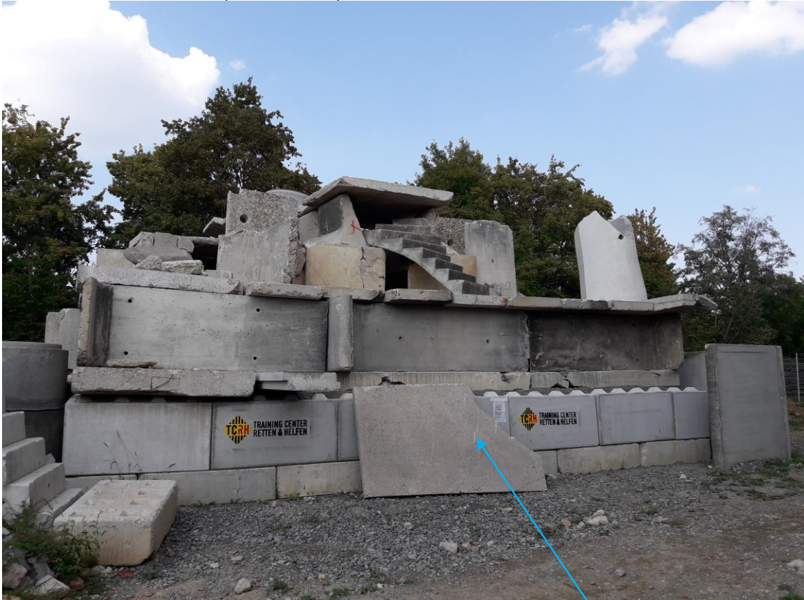
Bild 13: Mehretagenlabyrinth rechts vom Gebäude 4. Der Hauptzugang in die untere Ebene (1. Ebene) ist mittig hinter der Betonplatte.
